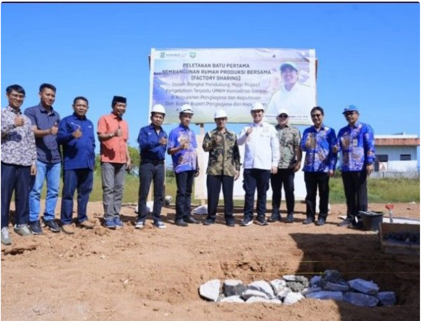
Peletakan Batu Pertama Pembangunan RPB Pengelolaan Garam
